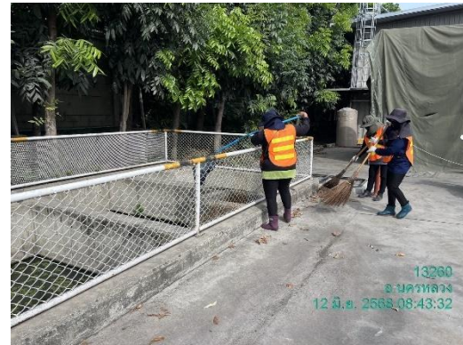
รูปที่ 2.2-21 การทำความสะอาดรางระบายน้ำ และบ่อตกตะกอนภายในโครงการ
