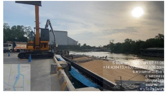
รูปที่ 2.2-17 การชิงผ้าใบหรือผ้าพลาสติกกระหว่างเรือลำเลียงสินค้าและท่าเทียบเรือ
